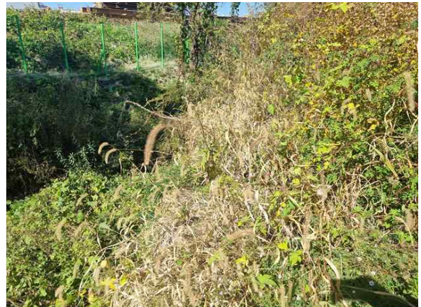
상부 성토부 전경
