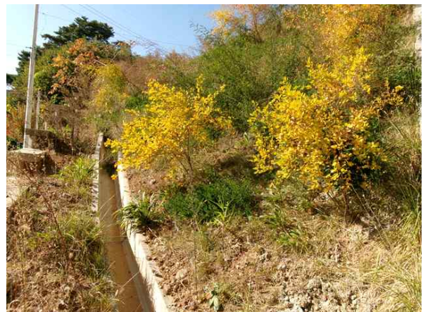
상부 성토부 전경
