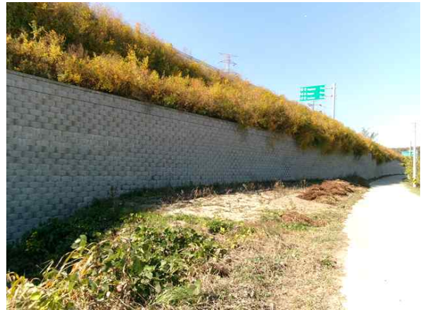
상부 성토부 전경
