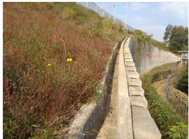
상부 성토부 전경
