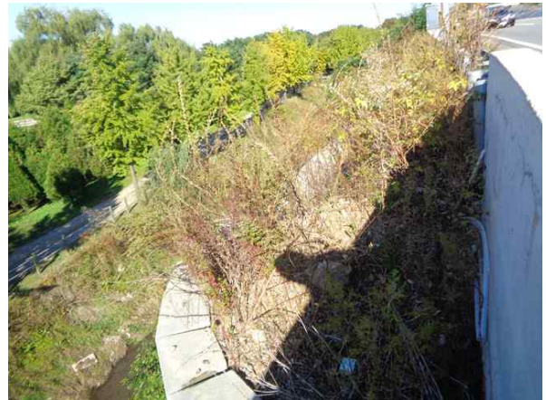
상부 성토부 전경
